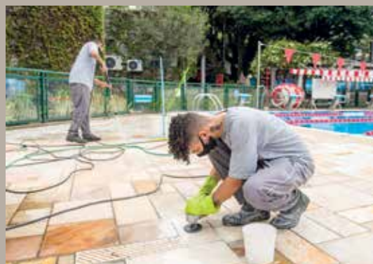
Polimento de pedras da piscina olímpica
