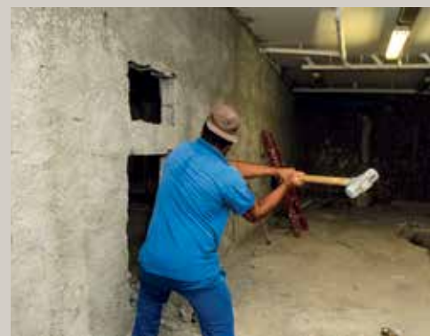
Obras para o novo vestiário familiar
