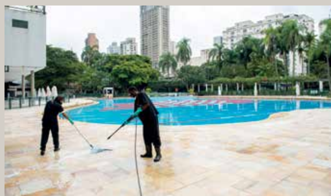
Limpeza de área da piscina social
