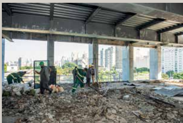
Remoção do piso do quinto andar do Prédio Novo
