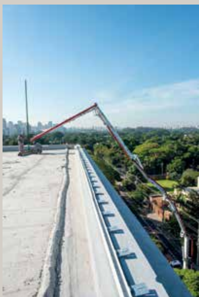
Operação leva concreto até cobertura do Prédio Novo
