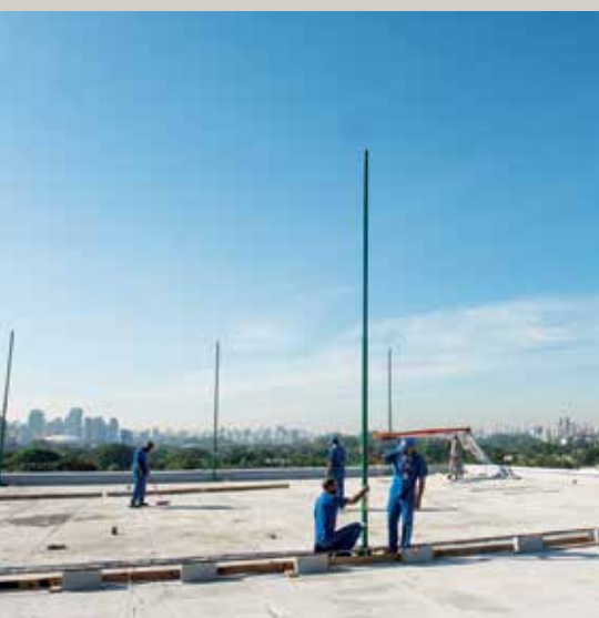
Postes para alambrados de quadras são colocados
