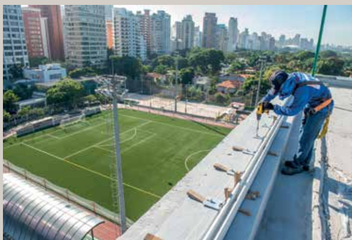
Esquadrias instaladas nos beirais da cobertura do edifício
