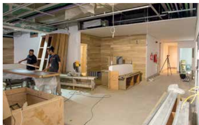
Complexo Ricardo Sampaio Vidal Gusmão será concluído nos próximos meses
