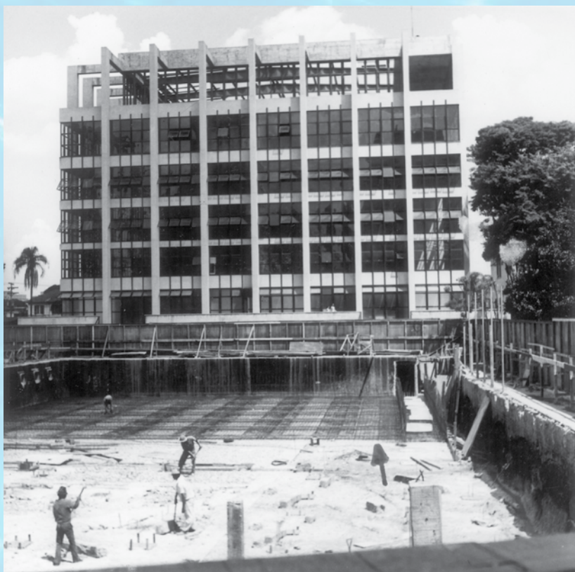
Construção da piscina fez parte de renovação do CAP
