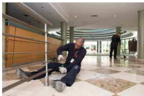
Boate teve luminárias de piso substituídas
