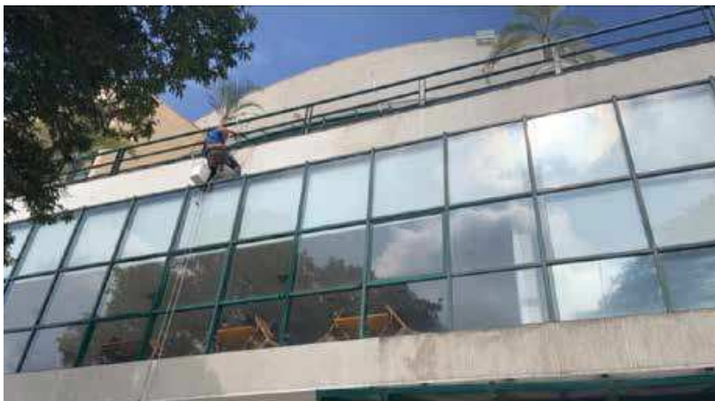
Empresa especializada realizou trabalho de limpeza na Sede
