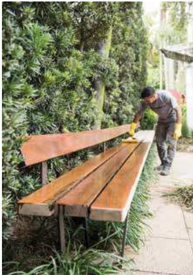
Diversos serviços de pintura foram concluídos em abril
