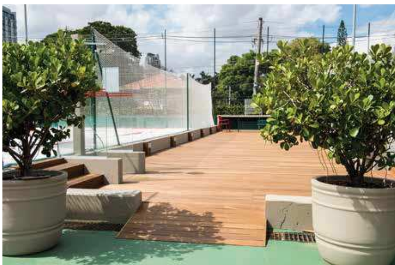
Está finalizado deck de madeira na área das quadras de areia
