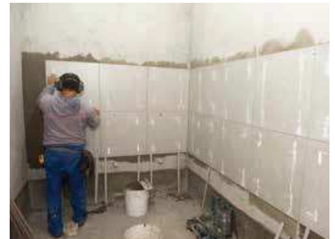
Vestiários subterrâneos recebem revestimentos
