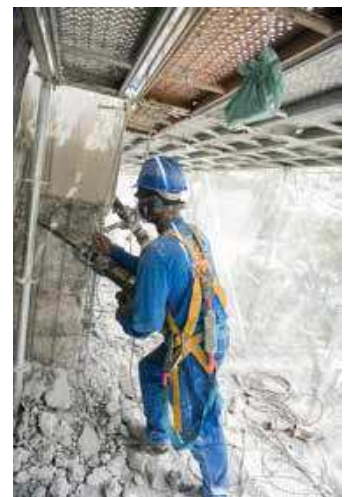
Pilares do Prédio Novo são recuperados em trabalho fundamental
