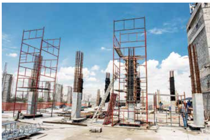
Pilares estão sendo concluídos no Prédio Novo
