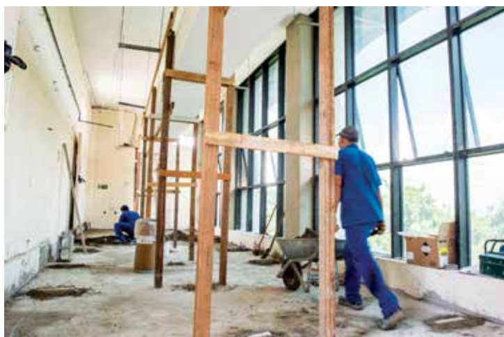
Área de escadas já demolidas são preparadas para novas utilidades
