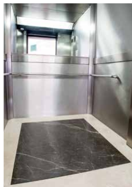
Piso de elevador do prédio da Sede foi trocado
