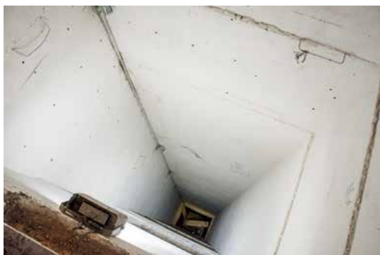
Intervenções finais para instalação de novo elevador no Prédio Novo
