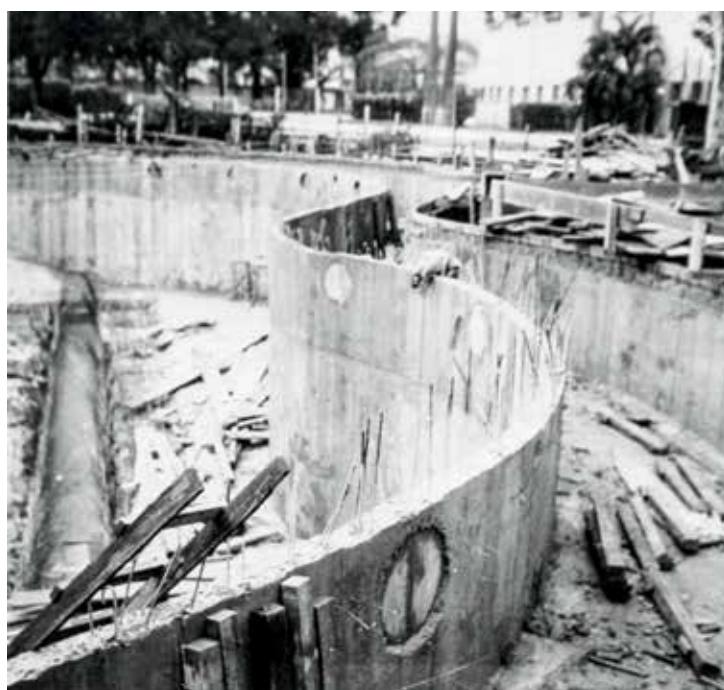
A construção da piscina social exigiu diversos cuidados especiais
