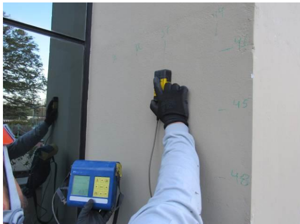
FOTO 51 – Realização do ensaio no pilar P13.
