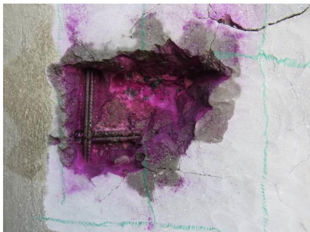
FOTO 53 – Realização do ensaio no pilar P05.
