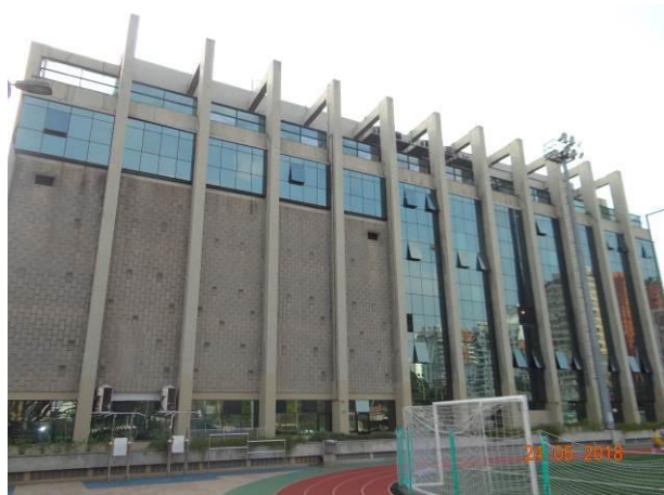
FOTO 1 – Vista geral da face Sul do Prédio Novo.
