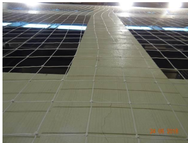
FOTO 16 – Disgregação do concreto indicando a corrosão da armadura embutida na face Oeste do pilar P74.
