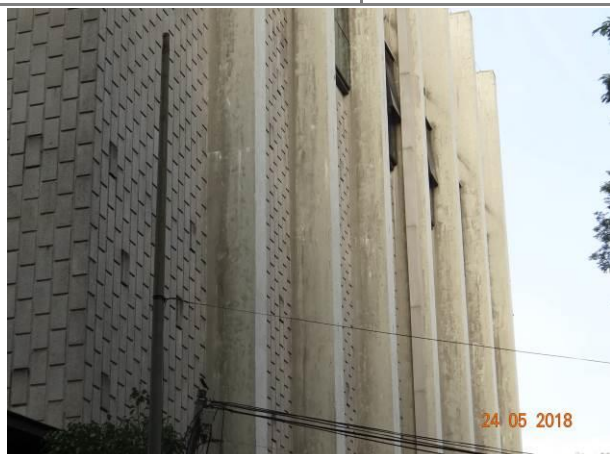
FOTO 39 – Vista dos pilares na Fachada Oeste.
