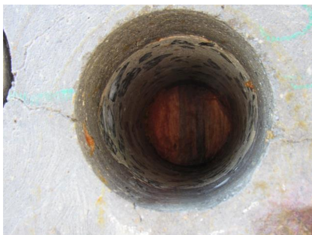
FOTO 47 – Detalhe do pilar P10. Observam as camadas de graute e concreto.
