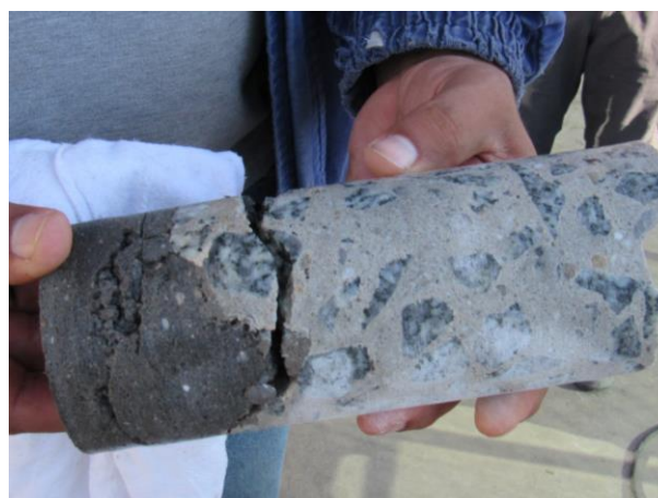
FOTO 50 – Detalhe do corpo de prova extraído do pilar P74. Nota-se a presença de vazios no graute.
