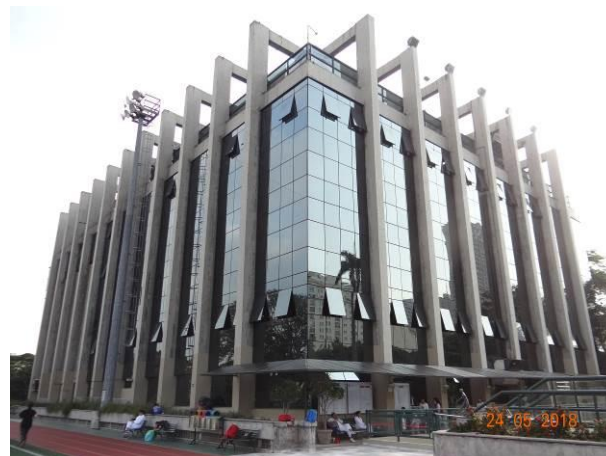
FOTO 2 – Vista geral do Prédio Novo.
