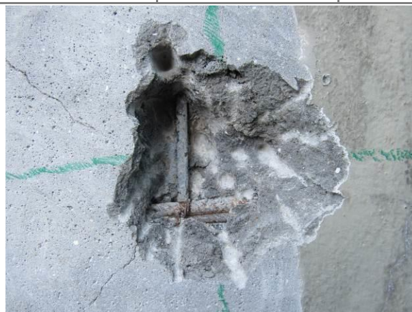
FOTO 46 – Ponto de prospecção no pilar P77. Nota-se a ausência de perda de seção da barra.
