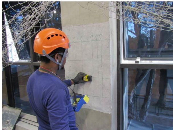
FOTO 52 – Realização do ensaio no pilar P22.
