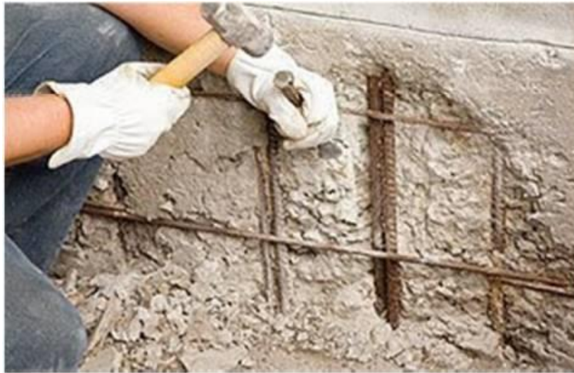
Figura 35 – Remoção do concreto com uso de martelo e talhadeira (Fonte: Silveira, 2009)
