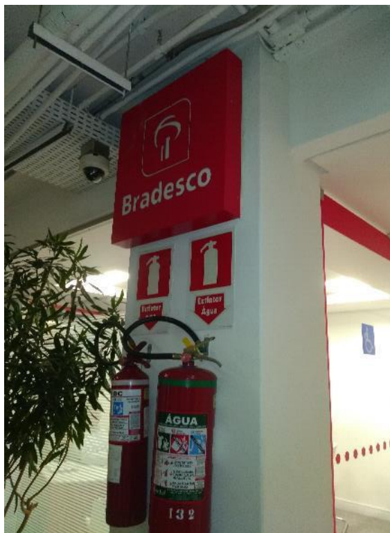
Figura 17. Pilares localizados no Piso Térreo – Agência Bancária
