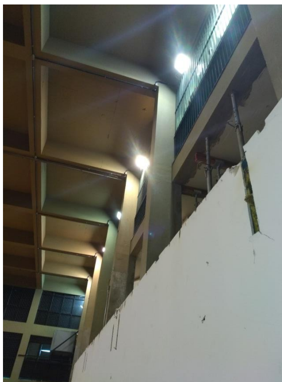
Figura 23. Pilares da quadra (1º e 2º Andar) – Notar a presença de grades e vigas entre os pilares
