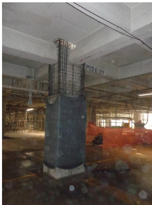
Figura 41. Exemplo de final de um período de cura de reforço de pilar (60MPa) com manta geotextil molhada periodicamente (foto: Desek)
