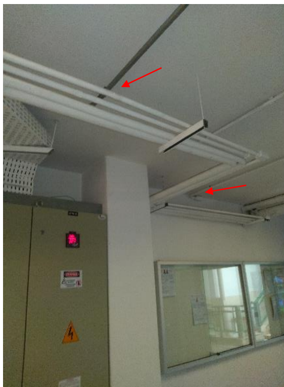
Figura 13. Piso térreo – Notar a presença de tubulações próximas ao pilar
