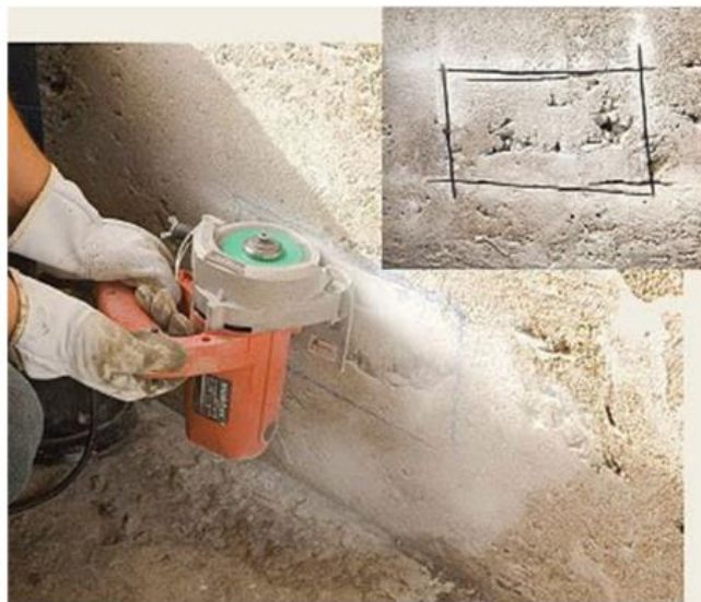
Figura 33 – Exemplo de corte em parede de concreto para delimitação da área para intervenção (Fonte: Silveira, 2009)
