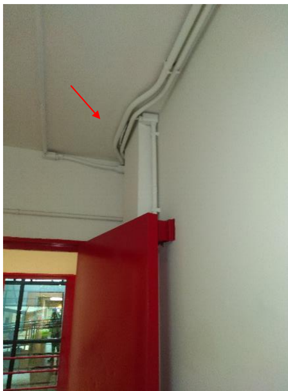
Figura 16. Piso térreo - Notar a presença de tubulações ao redor do pilar
