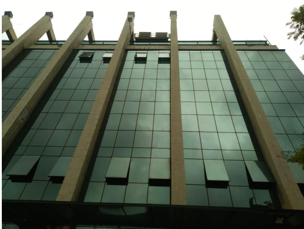
Figura 12. Fachada da Rua Estados Unidos – Notar pele de vidro no entorno dos pilares
