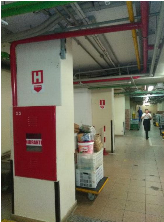
Figura 25. Pilares localizados no 1º Subsolo - Notar a presença de tubulações e instalações ao redor dos pilares
