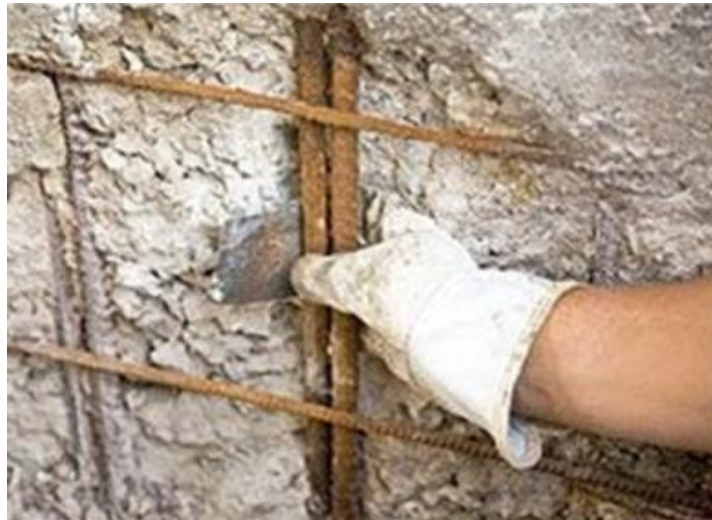
Figura 38 – Lixamento por trás da armadura utilizando lixa para metal (Fonte: Silveira, 2009)
