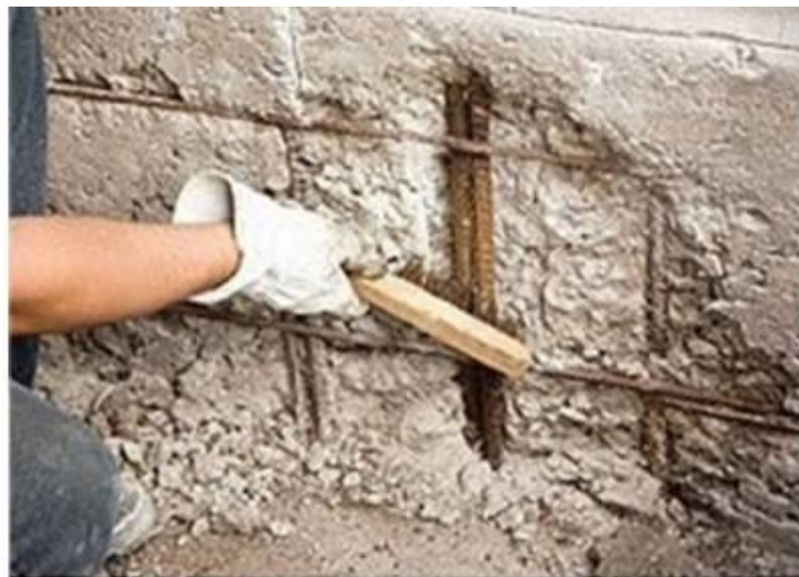
Figura 37 – Escovação da armadura com escova dotada de cerdas de aço (Fonte: Silveira, 2009)
