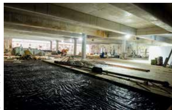
Obras de vestiários e saunas subterrâneos evoluem constantemente
